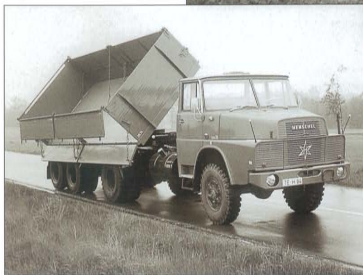
Henschel HS 19 HAS in überschwerer Exportausführung mit 13 t-Hinterachse und Allradantrieb (Dreiseitenkippaufleger: W. Wellmeyer)
