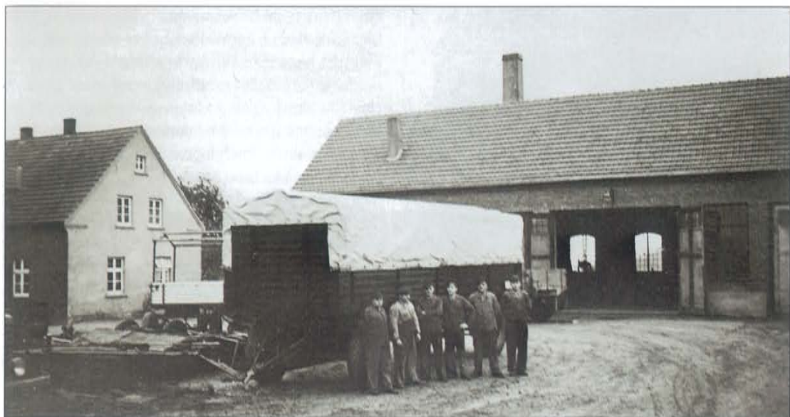
Der Wellmeyer-Betrieb in den fünfziger Jahren
