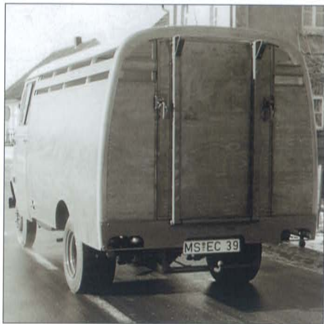
Mercedes L 319 Viehwagen in Sperrholz(!)-Konstruktion
